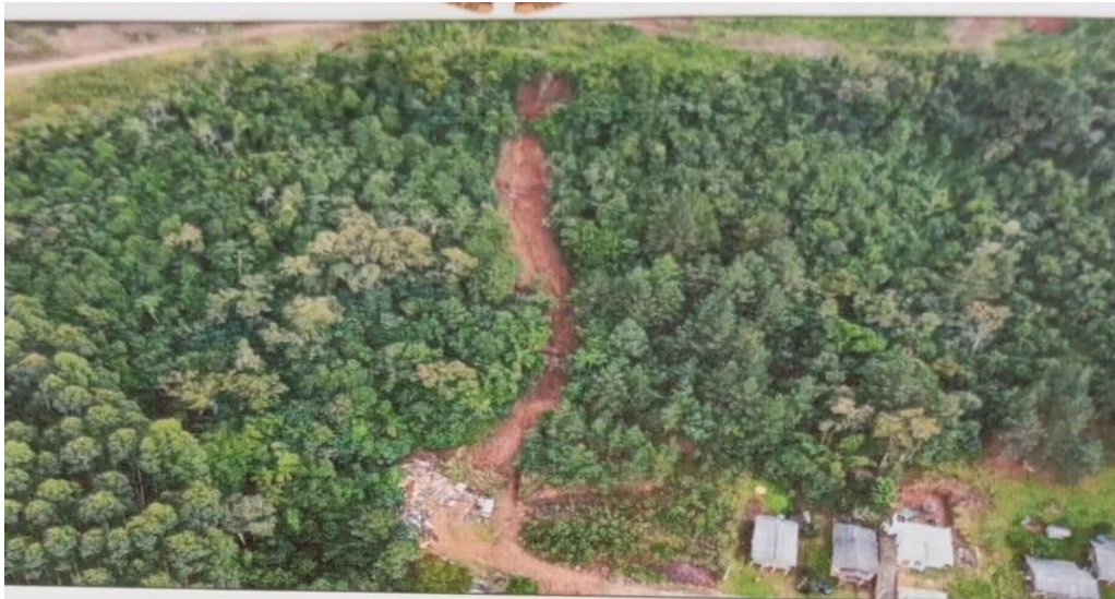
Imagem 5. Imagem capturada por drone em 21/06/2023. Fonte: Defesa Civil Municipal.
