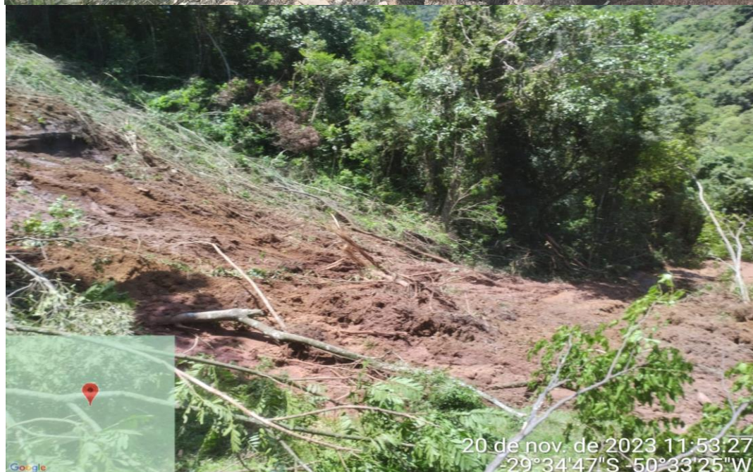
Movimentos de massa 2023 Fonte: Arquivo Defesa Civil
