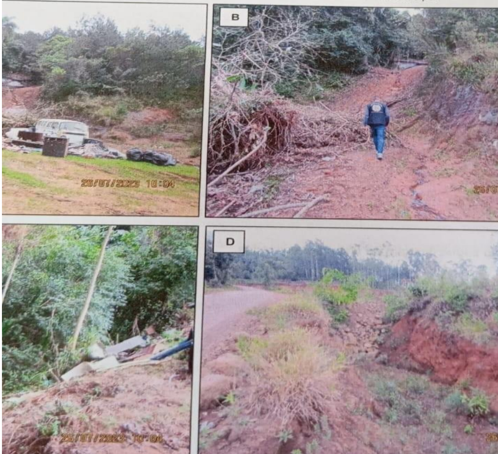
Deslizamento Bairro Rio Branco Fonte: Arquivo Defesa Civil
